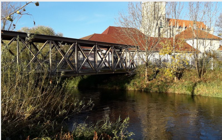
Passerelle de Doubs (CCGP)
