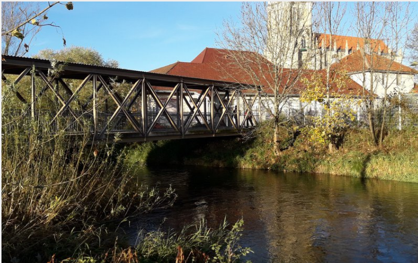
Passerelle de Doubs (CCGP)
